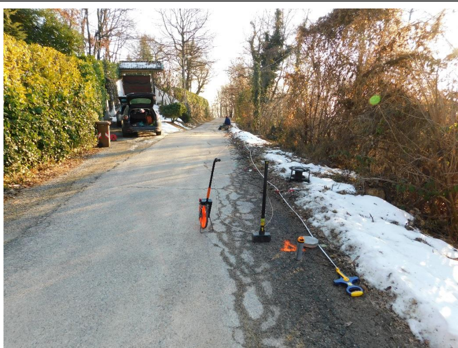
Foto 5. Vista strada oggetto di intervento
